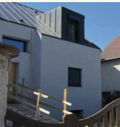
Au compteur, moins de 7 000 kwh par an pour tout : éclairage, électroménager, ordinateur (électricité d'origine hydraulique fournie par Enercoop) et eau chaude solaire.
