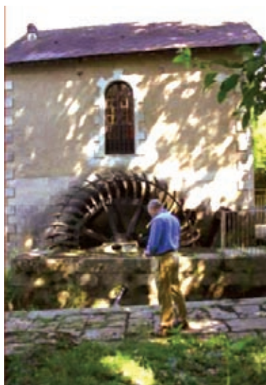
53-2. Moulin sur l'Anglin, Concremiers (36)
