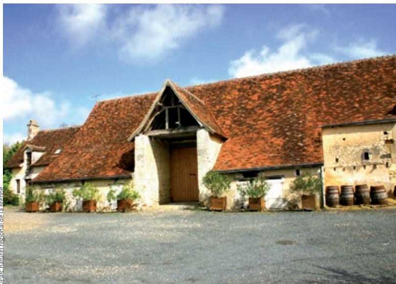
12-2. Grange à porteau à Chavannes, Azay-le-Ferron (36)
