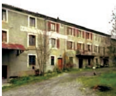
48-2. Façade de la minoterie
