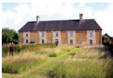
60-2. Le bâti en terre
