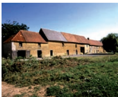
60-1. Le bâti en terre
