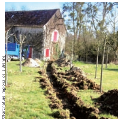
19-3. Surveillance archéologique de travaux d'enfouissement de réseaux, Durtal, Martizay (36)
