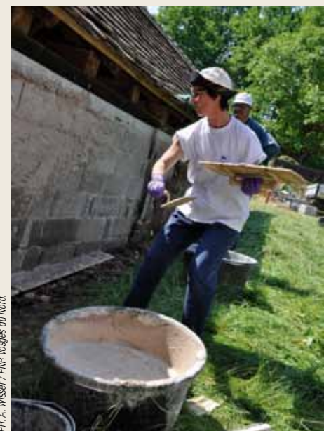
Dans les Vosges du nord, des chantiers sur le torchis ou, comme ici, l'enduit à la chaux.
