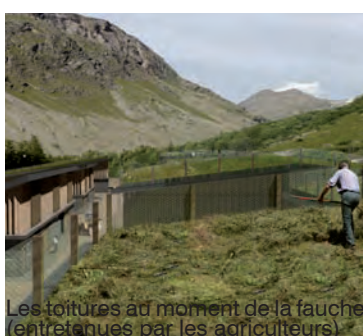
Vue éloignée sur le village et le projet
