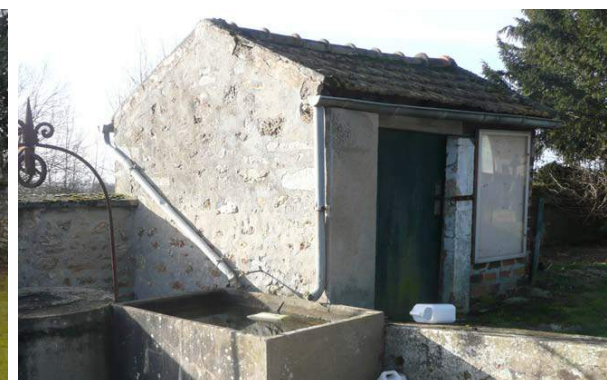
Fontenay-les-Briis (78), cabane avec récupération d'eau
