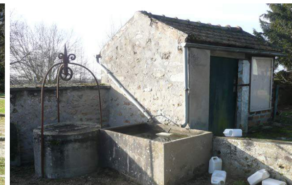
Fontenay-les-Briis (78), récupération d'eau de toiture
