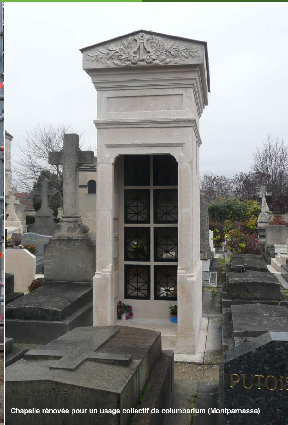
Travaux de restauration d'une chapelle pour un usage privé (Père-Lachaise)
