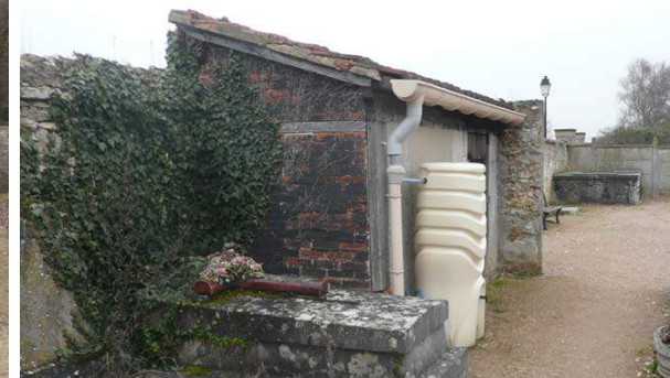
Bonnelles (78), cabane avec récupération d'eau
