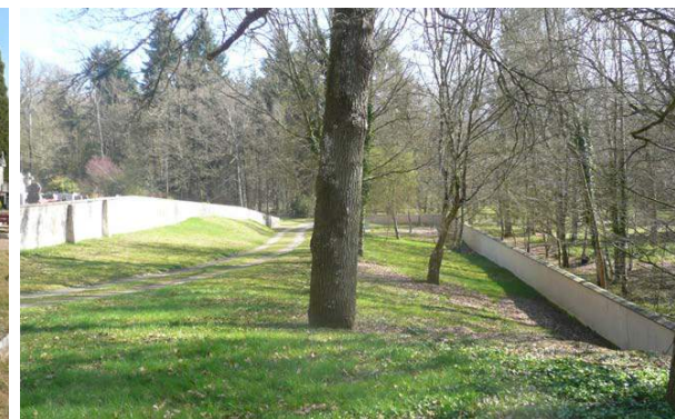
Auffargis : espaces en attente dans l'extension basse (78)
