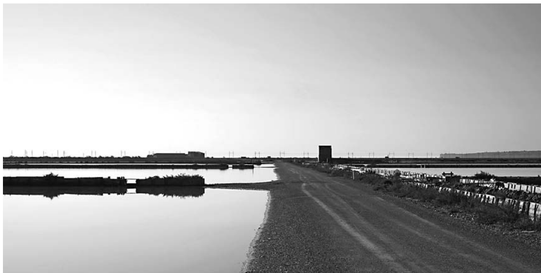
Les salins de La Palme après les travaux de remise en état de marche
