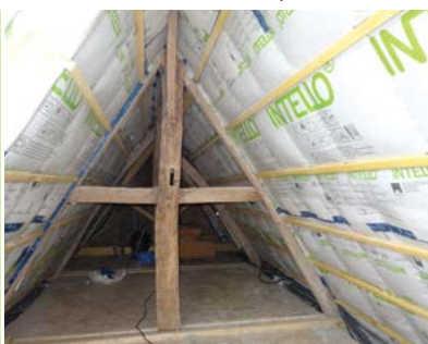
Isolation des rampants de toiture en ouate de cellulose à Le West
