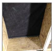
Isolation sous rampants ainsi que du pignon Est des combles en ouate de cellulose insufflée et pose de membrane d'étanchéité à l'air.
