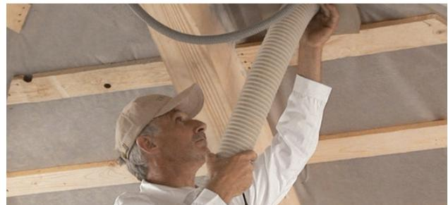
Exemple d'un opérateur insufflant de la ouate de cellulose sous rampant. Source : www.biofib.com.
