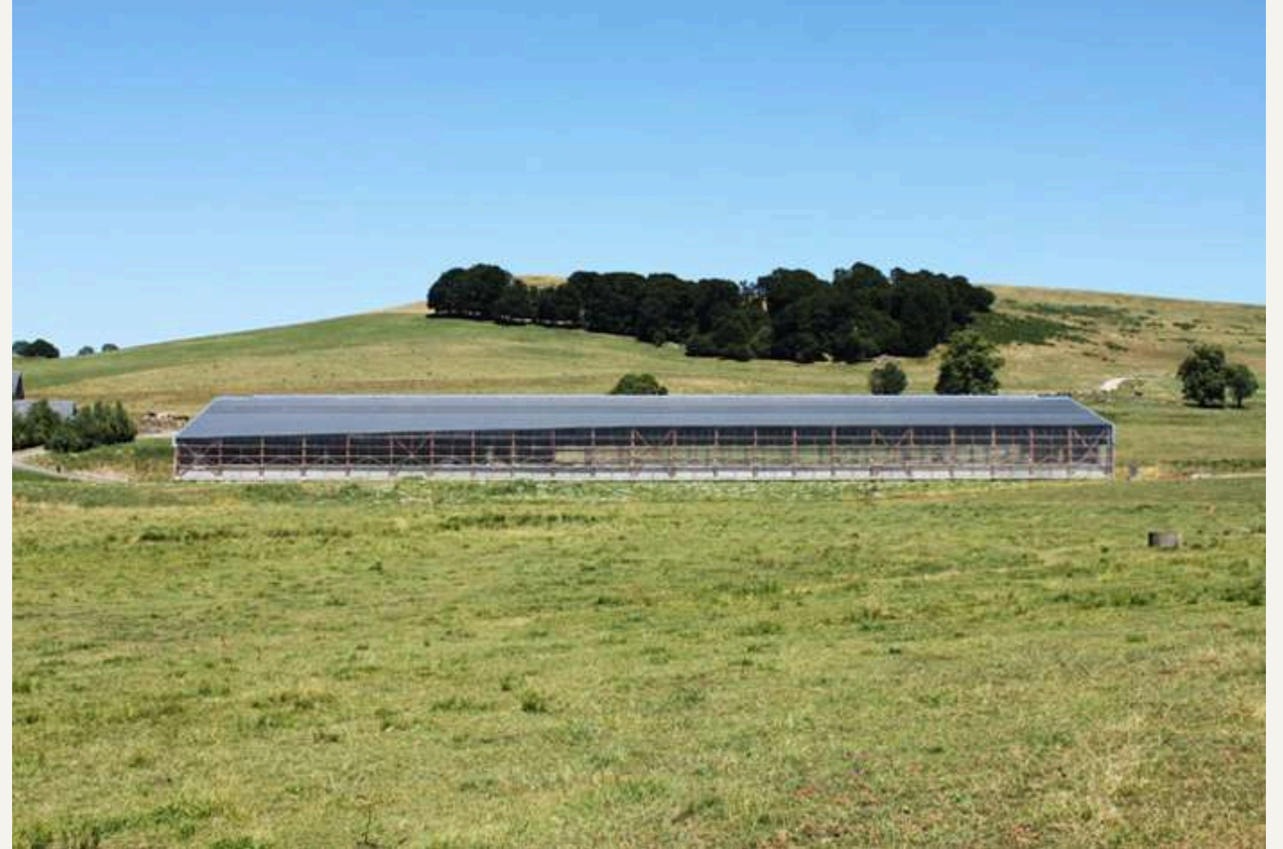
Bâtiment d'élevage expérimental à Marcurat, Fabriques architectures et paysages, 2014
