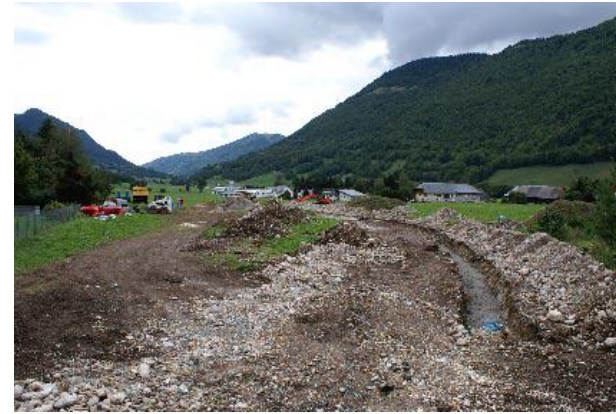
Vue du commencement des travaux du lotissement
