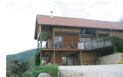
Une habitation dans la pente
