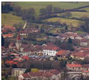
Vue du centre ancien de Ceyzériat
