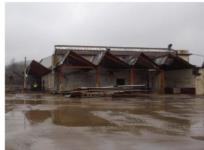
Filature en cours de chantier
