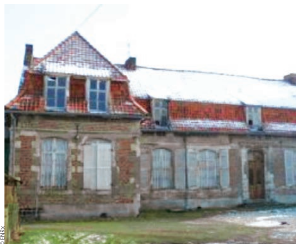
Etat actuel du château des douaniers.
