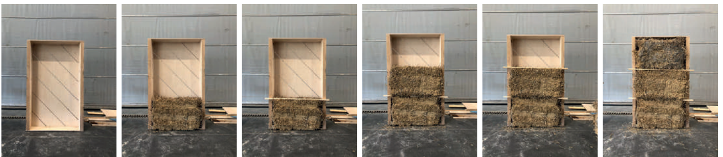
MISE EN OEUVRE DE L'OSSATURE REMPLISSAGE PAILLE
