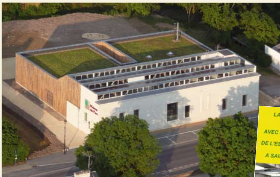
Loire-Anjou-Touraine : le toit intègre des panneaux solaires et la partie végétalisée stocke les eaux de pluie.
