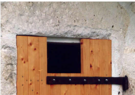
Photo 8.- Réalisation d'une ouverture dans une porte permettant l'accès à une bergerie dans l'Indre - Creation of an opening in a door giving access to a sheepfold in "Indre".
