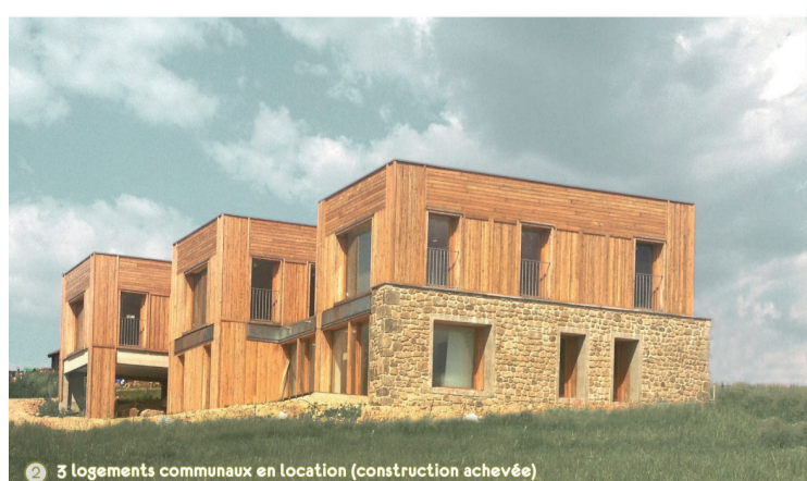
2 logements communs en location (construction achevée)
