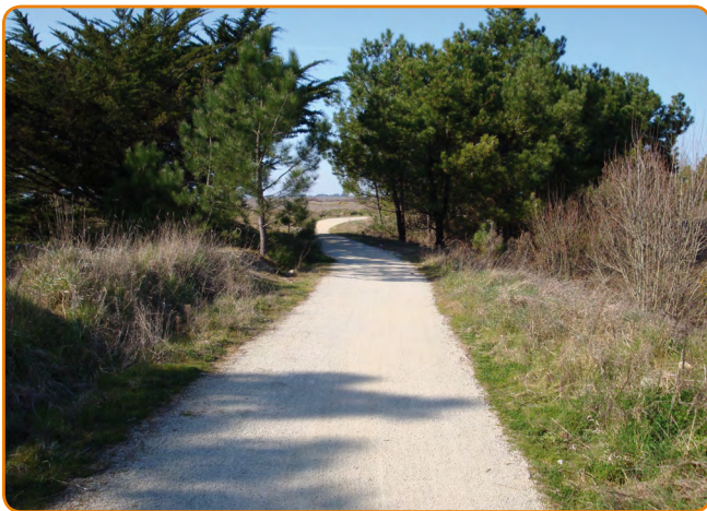
Voie cyclable littorale dans le massif dunaire de Gâvres-Quiberon : stabilisé sablé renforcé avec un liant minéral ( espace remarquable du littoral, site classé et site Natura 2000 ).
