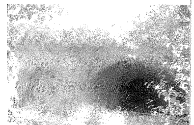
Galerie du canal Moulins
