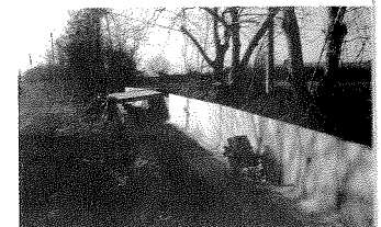
Bétonnage du canal
