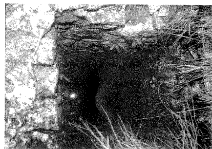
Regard permettant d'accéder à une galerie souterraine
