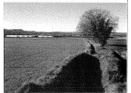
Canal d'irrigation taluté (Pertuis)
