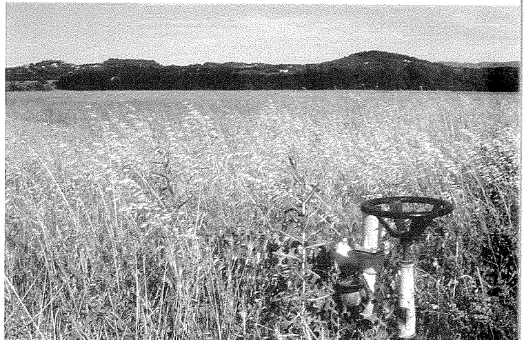
Une borne de distribution du réseau sous pression
