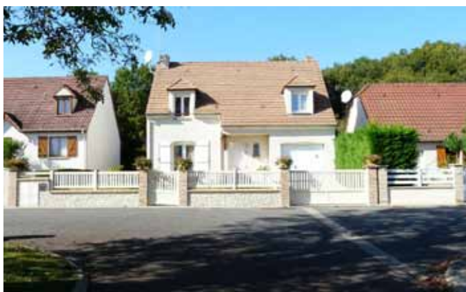
Les ensembles pavillonnaires actuels sont, pour la plupart, en rupture avec les spécificités architecturales locales.
