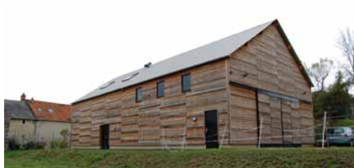
Chamarande, rythme créé en façade dû au relief apporté par l'assemblage des lattes
