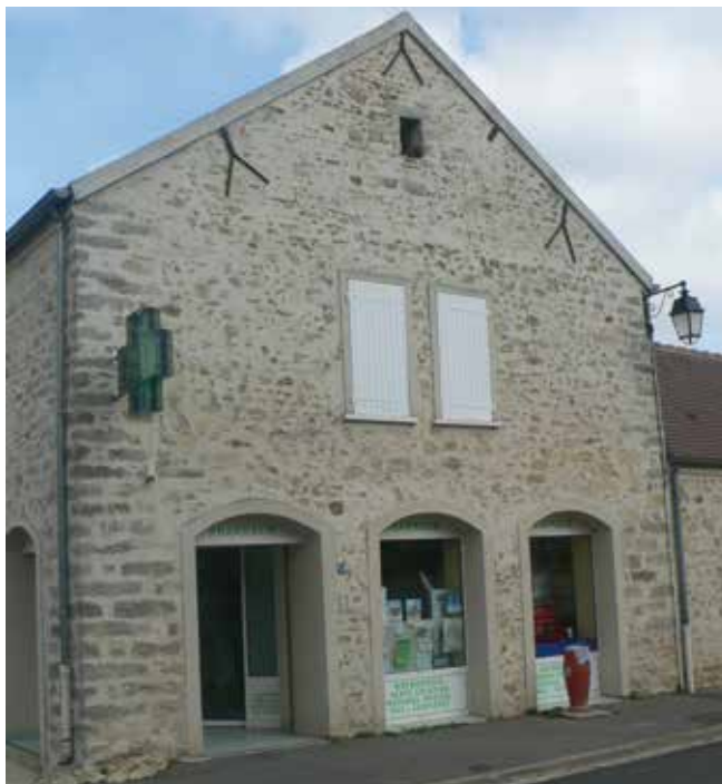
Une exemple d'intégration réussie : seule l'enseigne en drapeau indique la présence de la pharmacie.
