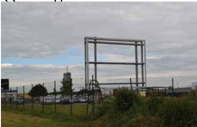
Ancienne structure accueillant un panneau publicitaire 4 m x 3 m.
