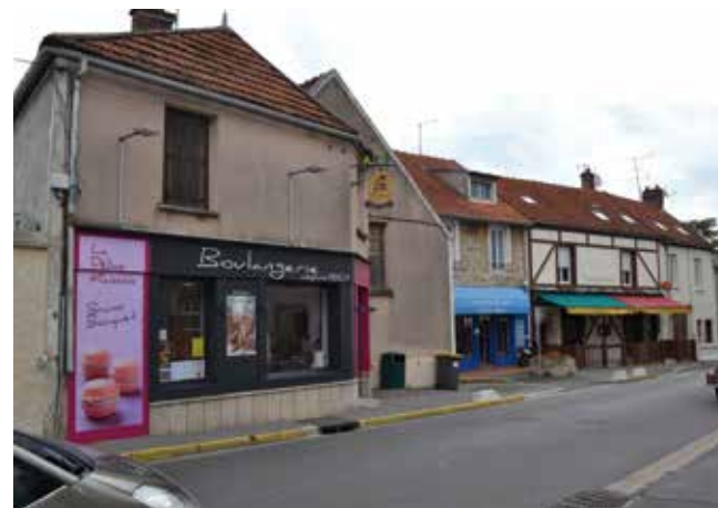
Ensemble de devantures non harmonisées entre-elles et sans intégration au bâti.
