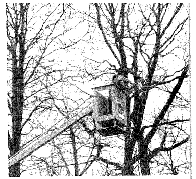
Elagage à la tronçonneuse à partir d'une nacelle
