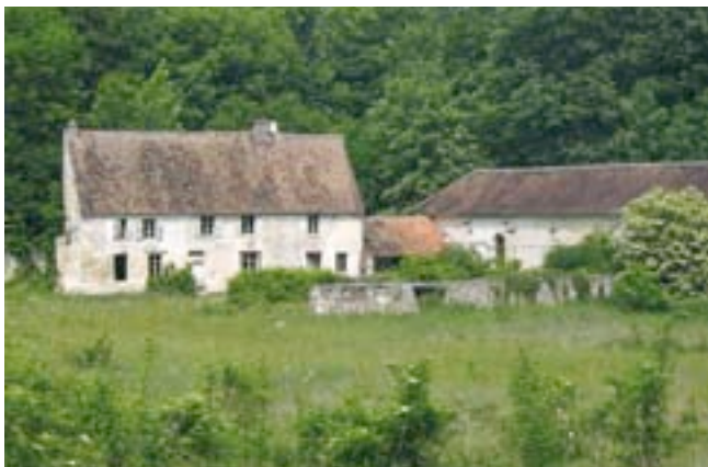
Anciens bâtiments agricoles laissés à l'abandon.
