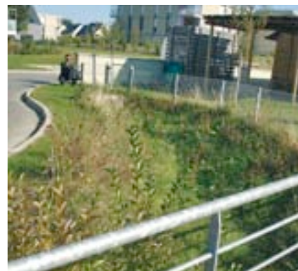
▲ Noues et fossés drainants : gestion extensive des eaux fluviales.
