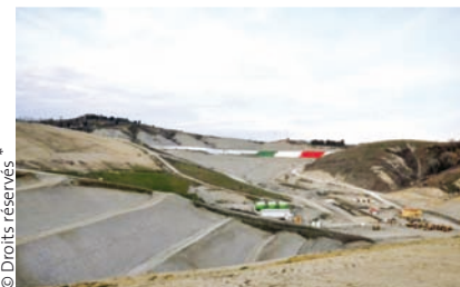
Vue de la décharge depuis la salle de réception
