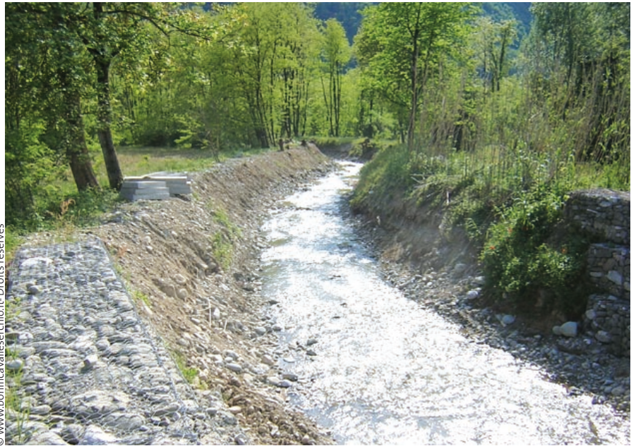
Aménagement à l'issue des travaux d'entretien.
