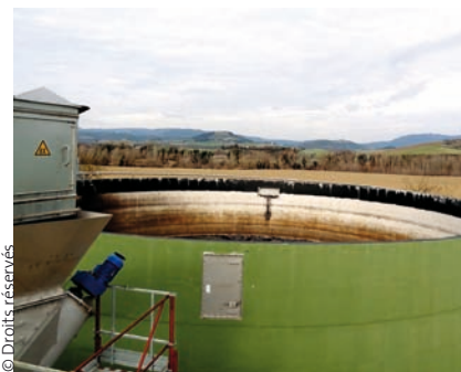
Stockage du lixiviat et des eaux de pluie
