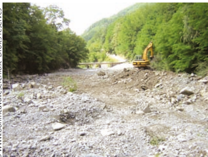
Travaux d'entretien en cours
