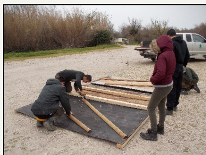
Construction des modules
