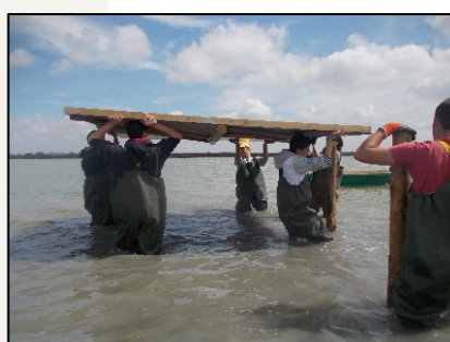
Installation de la plateforme
