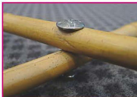
Faire un trou à la perceuse au milieu des deux tiges pour l'armature et y insérer le boulon et l'écrou ou le papillon comme sur la photo.
