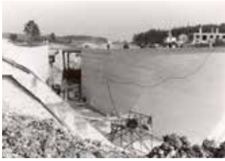
Création du Canal, des travaux d'envergure
