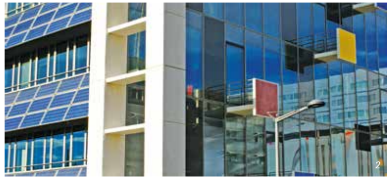
1//Parc solaire d'Espinasses(05),2//Panneaux solaires – Lyon Confluence(69)
