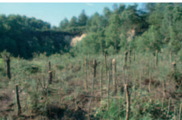
Site des Egoutelles pendant les travaux.
