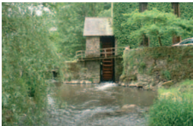
Moulin de Boistard après les travaux.
