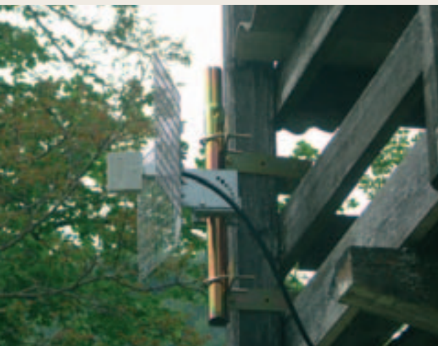
Une antenne utilisateur.
