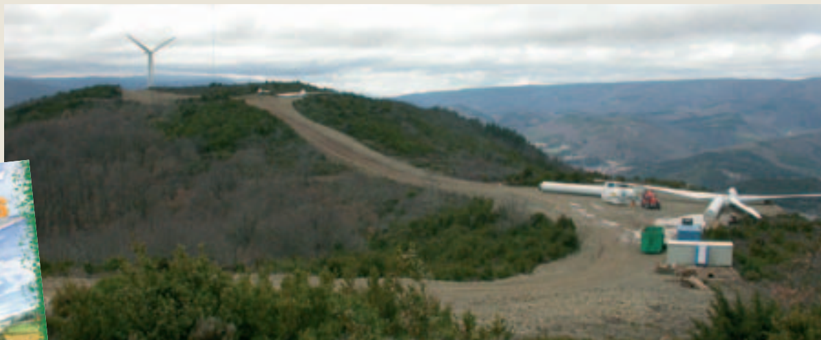
Montage d'éolienne dans le Haut-Languedoc
