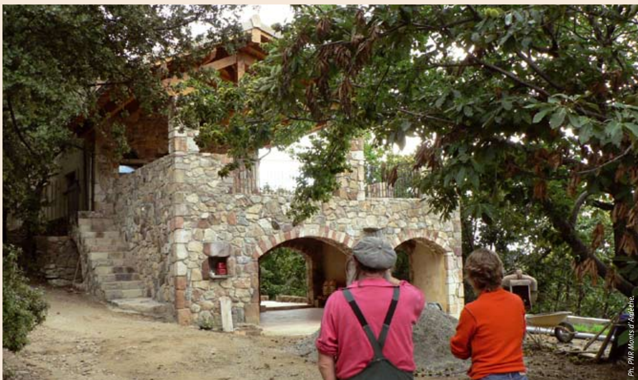
Un gîte en chantier bientôt marqué dans le Parc des Monts d'Ardèche.
