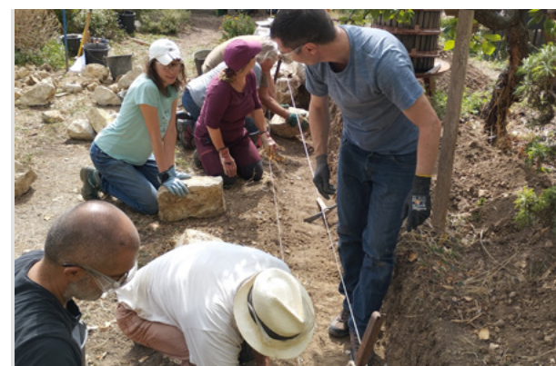
► Chantier d'initiation à Saint-Jeannet (06). © PNRPA
